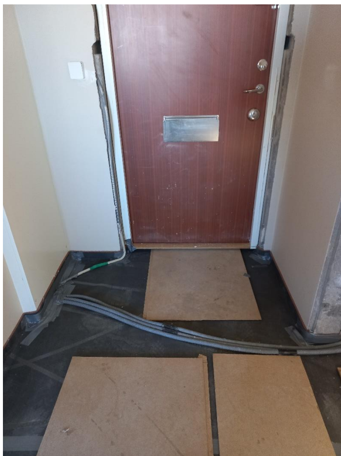
Bild 2 ljudmatta och elledningar på plats
