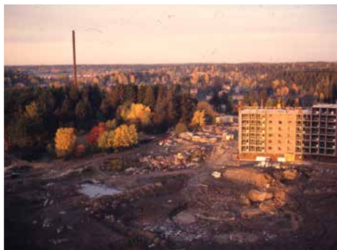
September 1969: Storstugan under "montering", Åkerbyvägen 82-84, samt schaktning för fontän och pool.
