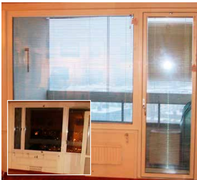
Lilla bilden: Fönsterpartiet i vardagsrum före bytet Stora bilden: Samma fönster efter bytet
