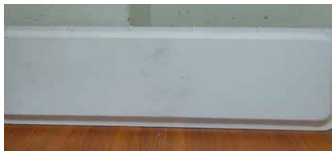
Fram- och baksida på de tilluftdon som Storstugan utrustades med när husen byggdes. I donets överkant en cirka 3 mm bred springa där luften styrdes upp mot element och fönster.
