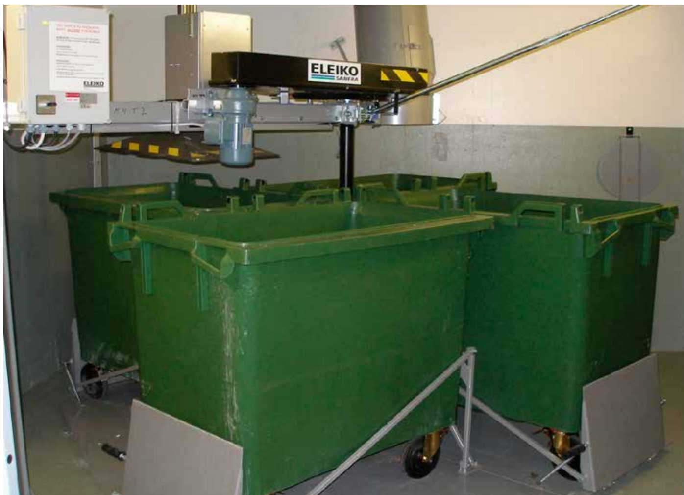
Feb - mars 2005: Nya karuseller för sopkärl på hjul installerade.
