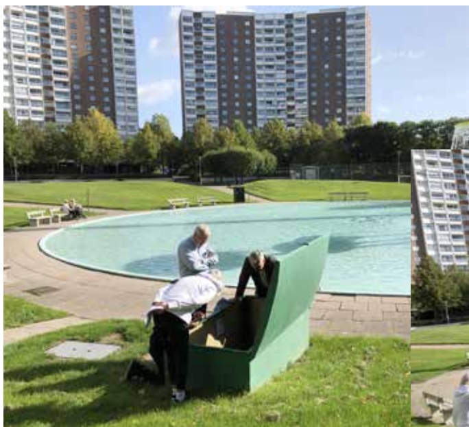
Besiktning av fontänen
